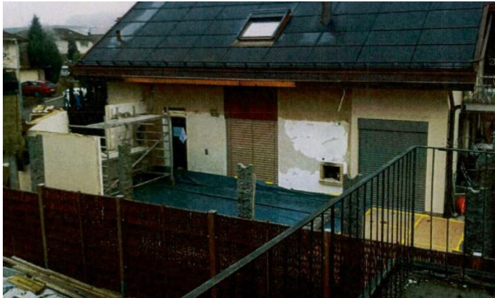
Abb. 1 Fotoaufnahme der Bauarbeiten, dem Gemeinderat mit E-Mail vom 17. Januar 2022 von den Beschwerdeführenden eingereicht
