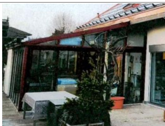
Abb. 2 Vorher: Südostfassade mit Falttüren und Verglasung in Dachschräge
