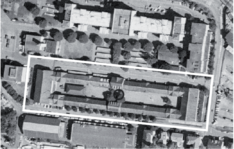
Complexe de bâtiments MK II, avec cour intérieure
