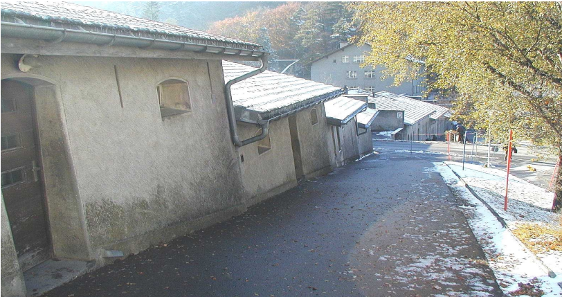
Vue de la façade nord-ouest du groupe de bâtiments sud Partie inférieure de l'ensemble de bâtiments situés au-dessus de la route cantonale (futurs cantonnements)
