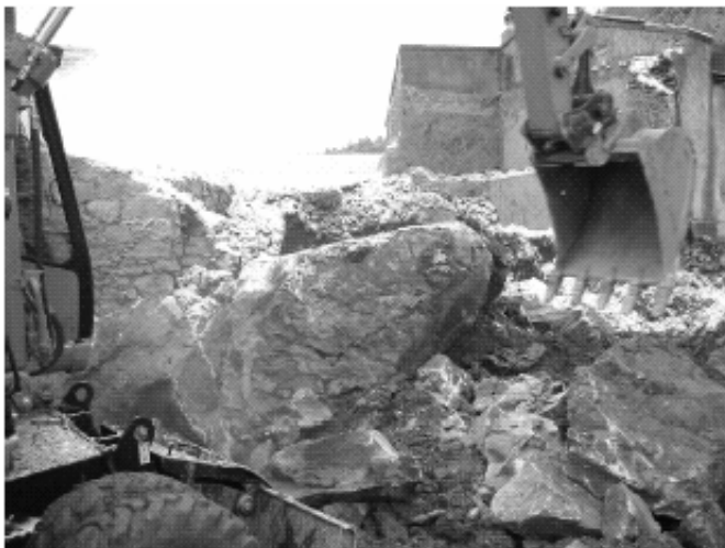
Excavation de blocs erratiques dans la zone du magasin souterrain de la troupe
