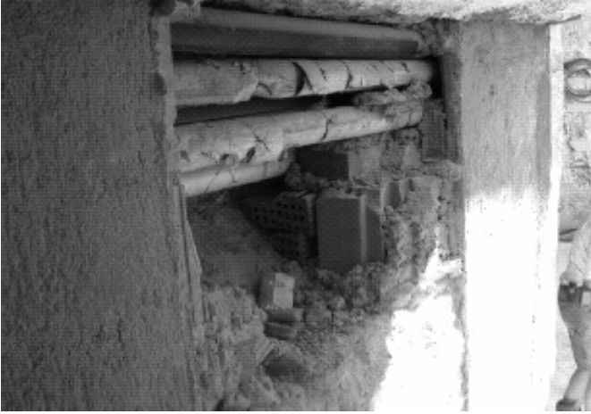
Assainissement des murs
