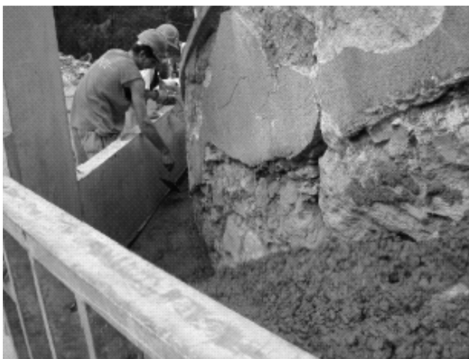
Construction en sous-œuvre des fondations de façades
