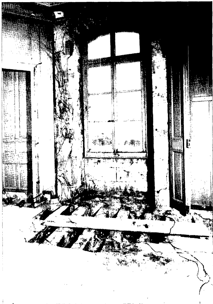
Salle 1109: La vigne vierge a traversé les façades et est venue se loger entre les panneaux boisés et la molasse; apports d'humidité et de champignons. Au sol poutres et plancher pourris.
