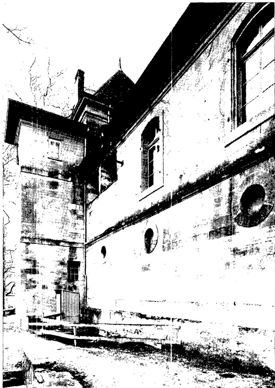
Façade nord-est: La tour sanitaire sera maintenue. Autour de la descente des eaux pluviales, dégâts dus à l'eau. Traces d'anciennes ouvertures. Soubassement, crépis au ciment très désagrégés. Joints fusés.
