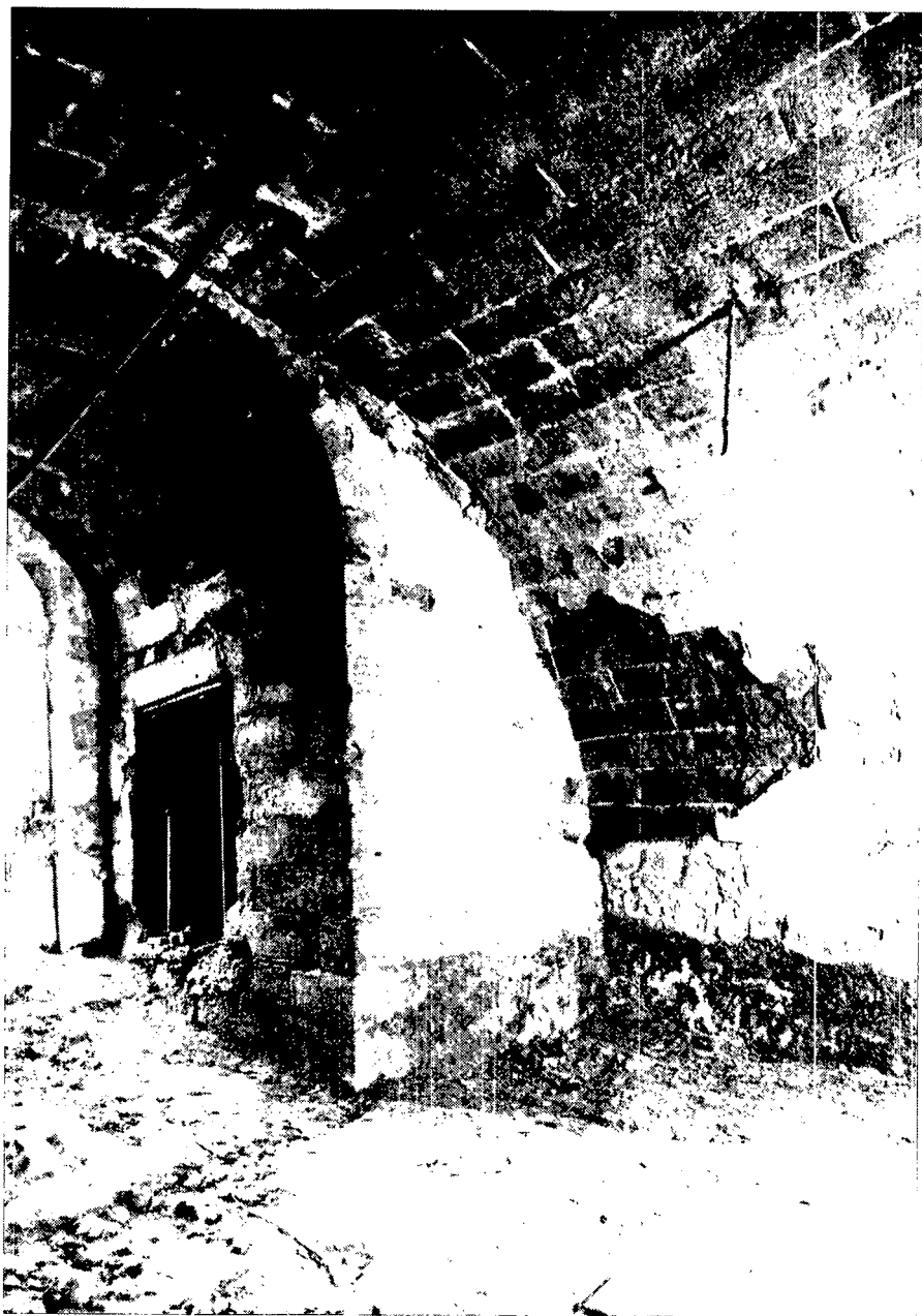
Serre souterraine: Molasses en très mauvais état, atteintes par l'humidité; danger d'affaissement.
