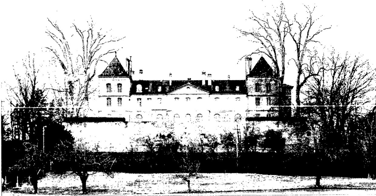
Vue d'ensemble sur la façade sud-est depuis les abériaux. Essais sur les menuiseries extérieures et sur une lucarne.
