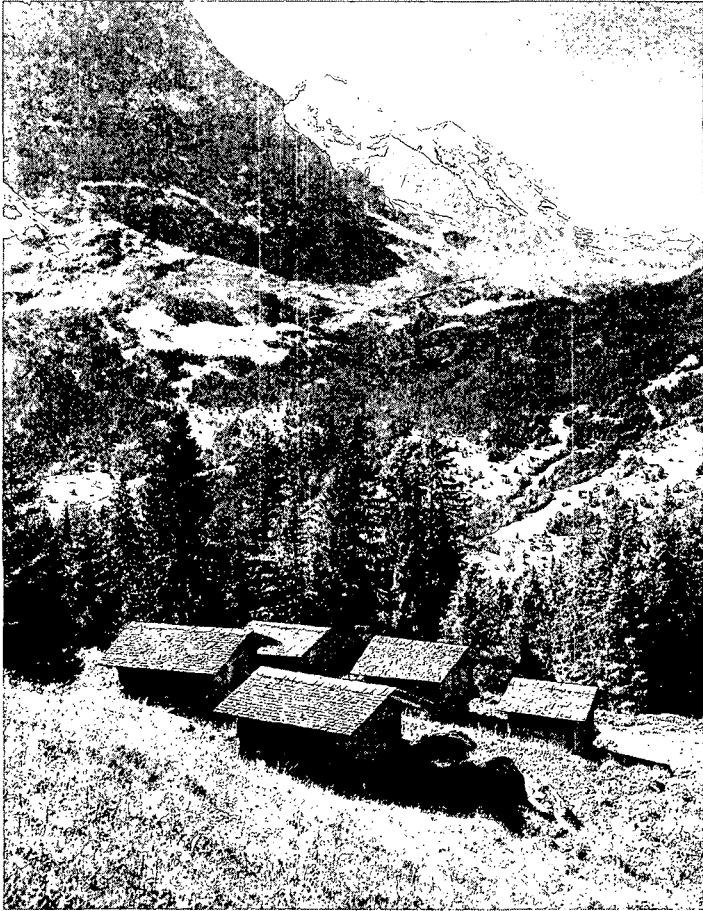
La rénovation et la reconstitution de toits en bardeaux
