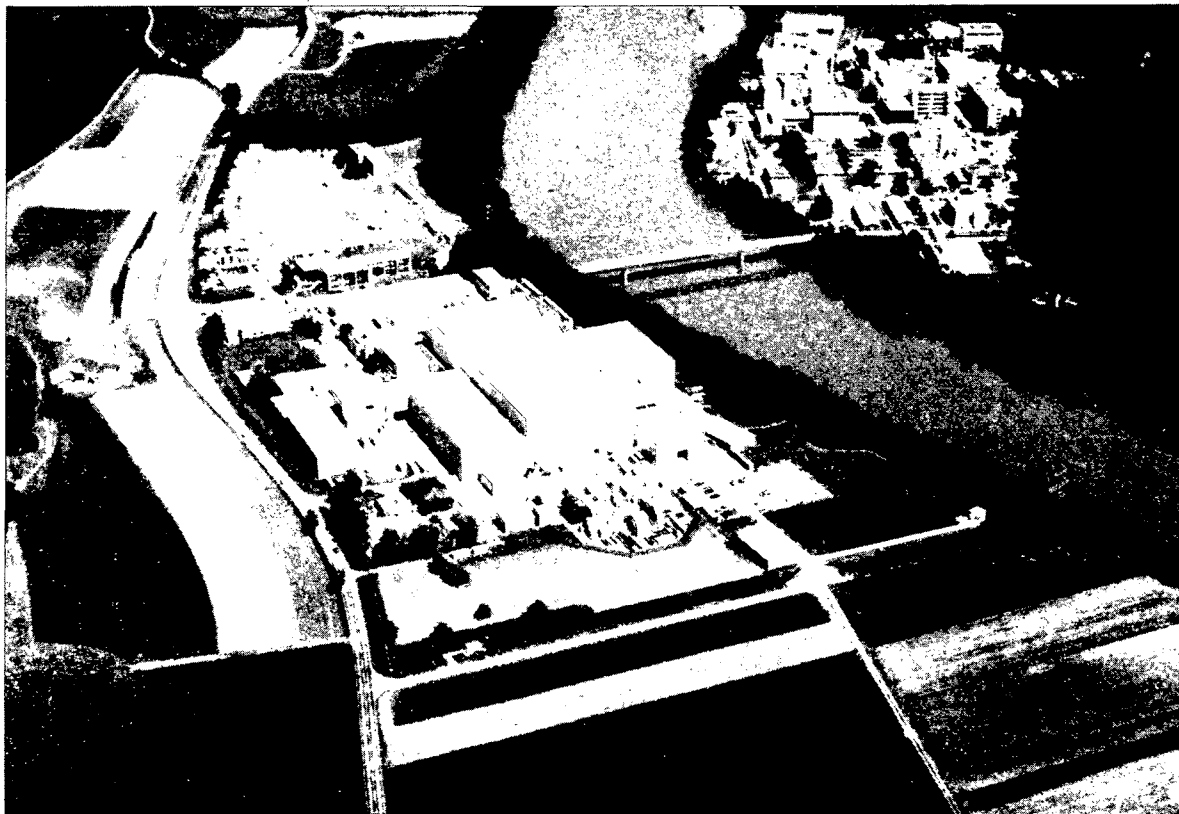
Vue du sud. A gauche l'aire ouest (commune de Villigen), à droite l'aire est (commune de Würenlingen).
