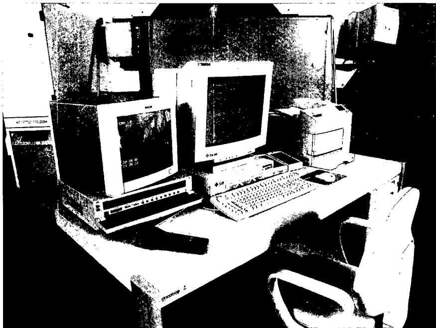
Station de commande et de surveillance
