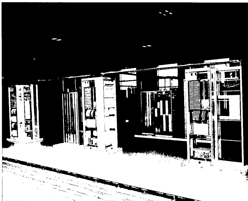
Réseau pilote construit en halle à des fins d'essais
