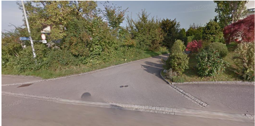
Einmündungsbereich der M. ___ in die N. ___ strasse mit unterbrochenem Trottoir
