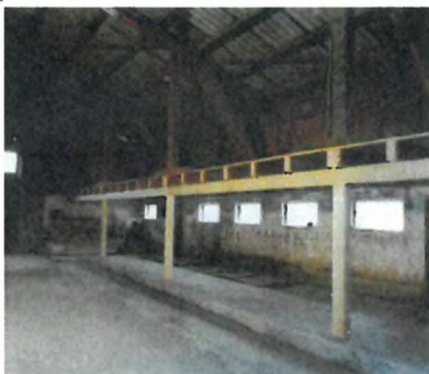
Scheune Vers.-Nr. 001, neuer Zwischenboden mit neuen Stützen
