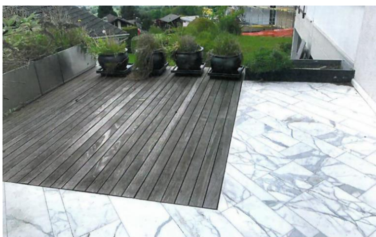
Terrasse auf der überdachten Pergola
