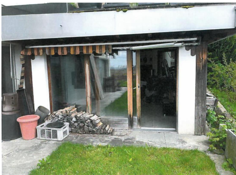
Ansicht Westfassade der Pergola
