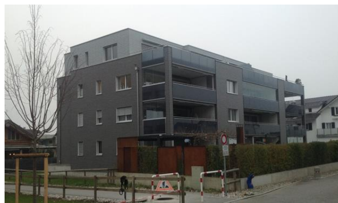
Nordost- und Südwestseite des Mehrfamilienhauses an der M. ___ strasse 1
