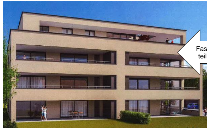
Südwestseite des Mehrfamilienhauses an der M. ___ strasse 2 (gemäss Fotodokumentation des Rekurrenten)
