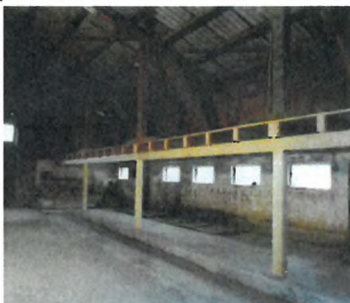
Scheune Vers.-Nr. 001, neuer Zwischenboden mit neuen Stützen
