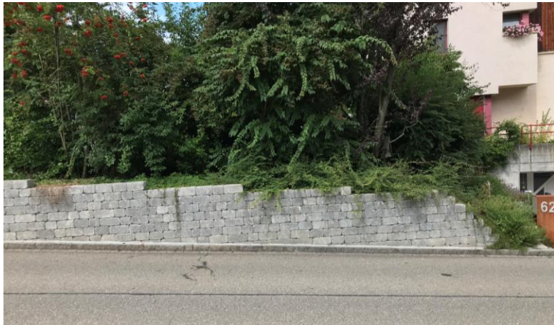
Zustand nach Erstellung der Mauer (24. August 2020)
